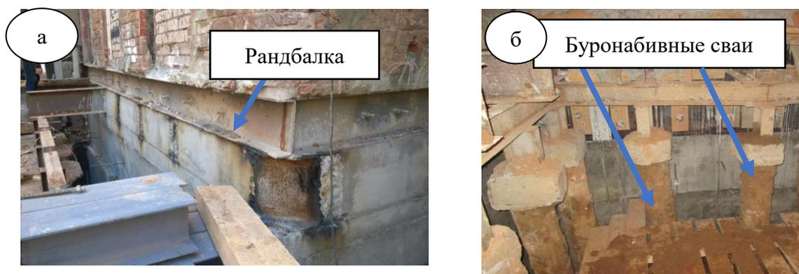
Рисунок 8 – а) устройство рандбалки; б) устройство буронабивных свай
