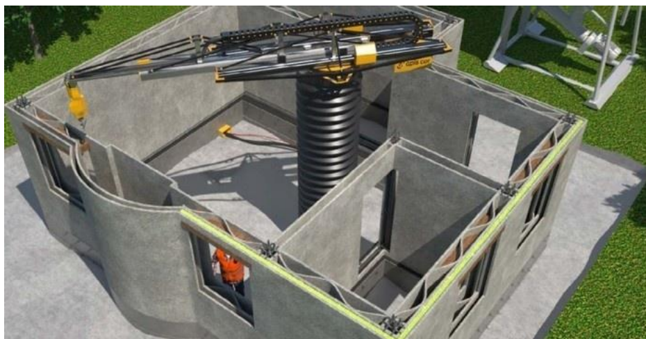
Рис. 1. 3D печать стен здания ( http://rusalla.ru/post420058218/ )
